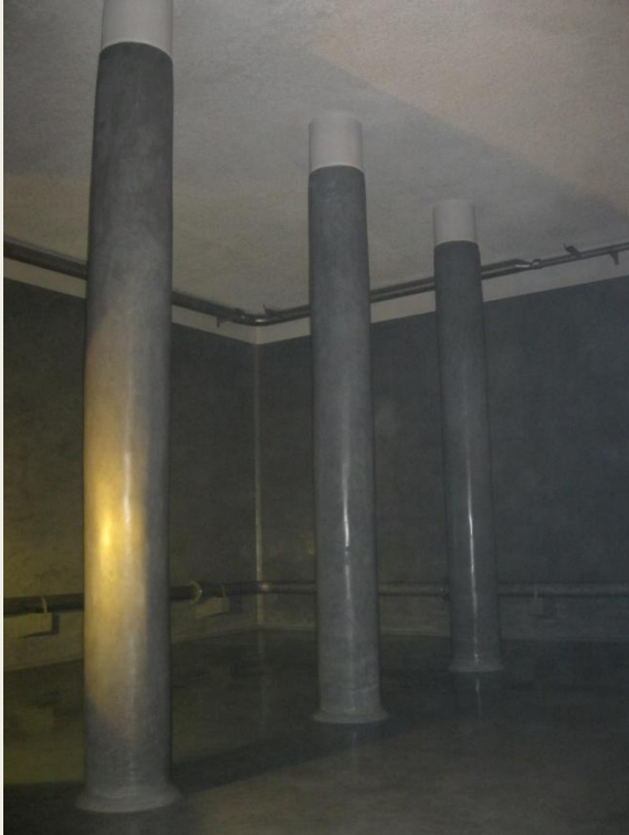
linke Wasserkammer nach Sanierung
